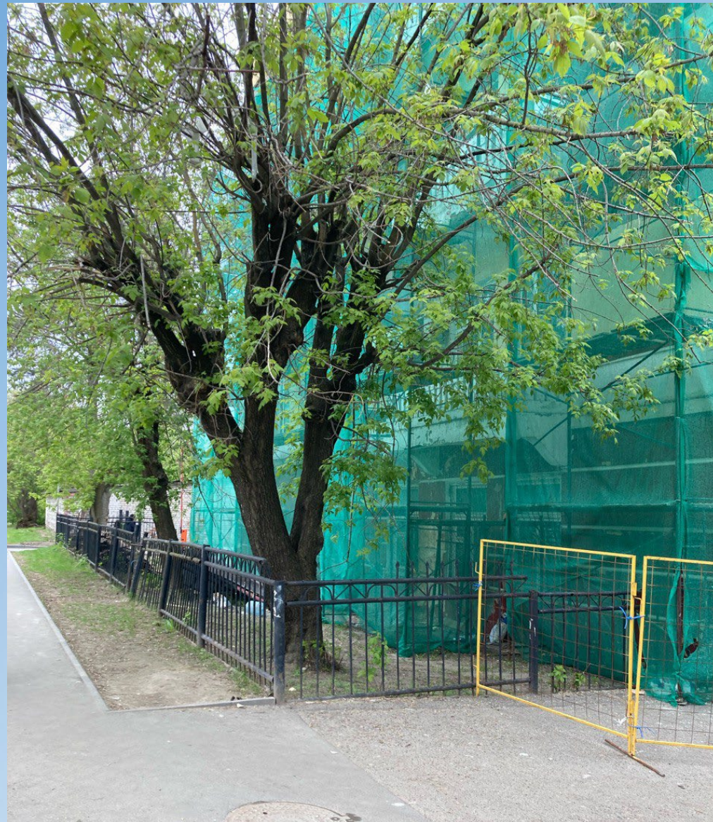
Ограждение, строительные леса
